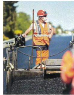
10% des enrobés de l'ancienne couche de roulement seront recyclés dans la fabrication de la nouvelle chaussée.
