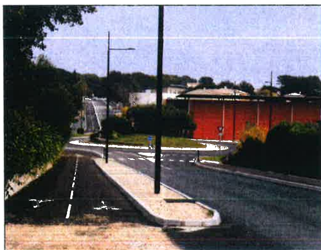
Aménagements doux sur l'avenue du Pic, à Vergèze
