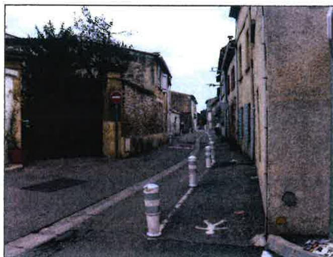
Voirie partagée sur la rue de la Monnaie, à Codognan
